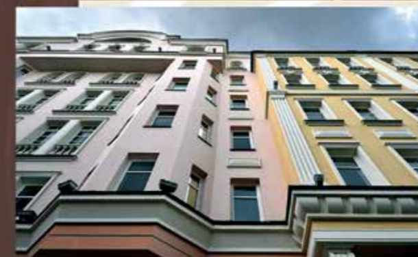
Комплекс административных зданий на Большом Кисловском
